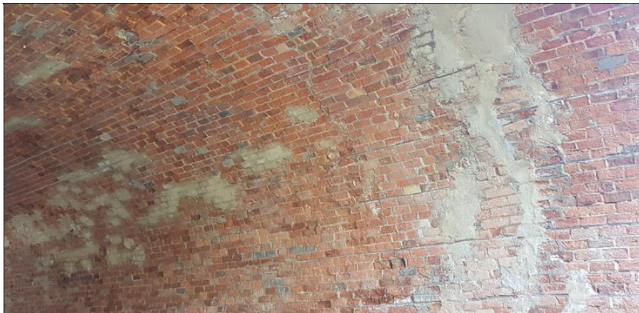
pěkně opravené trhliny v klenbě
