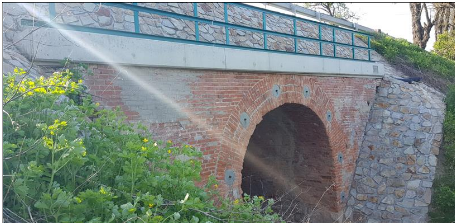
klenba stažená předpínacími lany - levý portál
